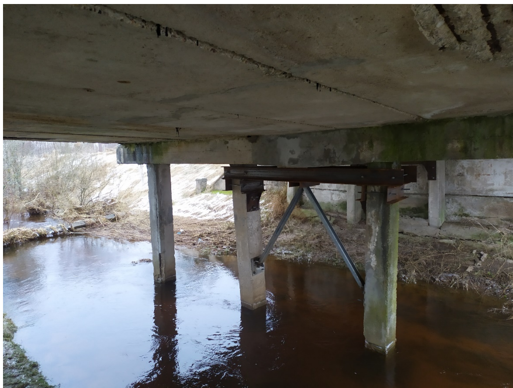
6 pav. Deformaciniai pjūviai nesandarūs
